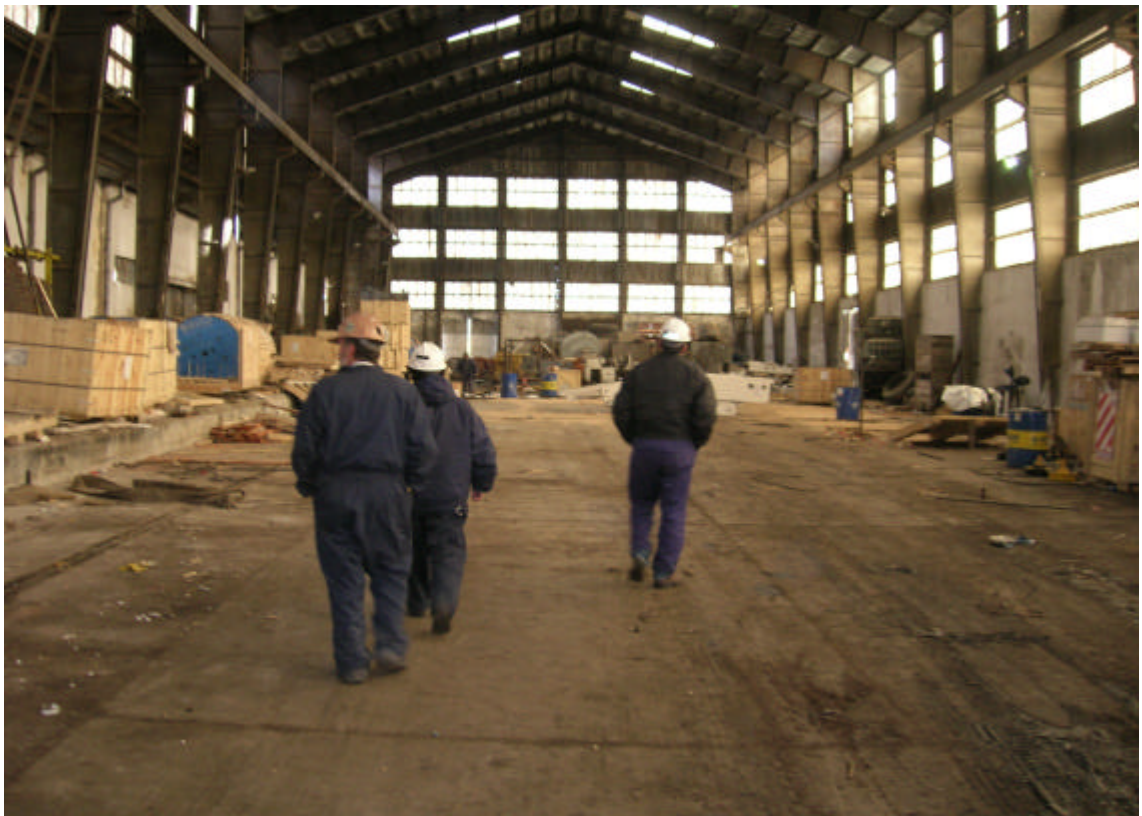
Galpones reacondicionados para tareas de mantenimiento. Año 2007.
