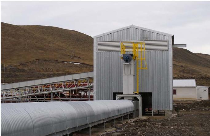
Circuito del carbón transportado desde el yacimiento Río Turbio a través de la cinta cerrada (11 km) para evitar voladuras de particulado. Una vez en el predio de la planta, el carbón es acopiado en dos pilas (una de 61.000 m<sup>3</sup> y otra de 39.000 m<sup>3</sup>), que contarán con un sistema de captación y tratamiento de lixiviados.
