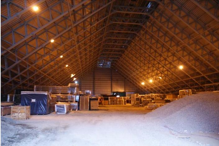
Galpón de almacenamiento de cenizas(75 Tn/ h). Estas son movilizadas a través de cintas transportadoras cerradas y estancas hasta el almacén transitorio de cenizas. El depósito se realiza en un recinto cerrado, estanco y deprimido con un sistema de captación de polvos, que tiene una capacidad para el acopio de 15 días de generación.
