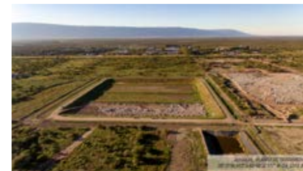
SECTOR MÓDULO DE DISPOSICIÓN FINAL Y LIXIVIADOS (8.1.1, 8.1.10, 8.1.11)
