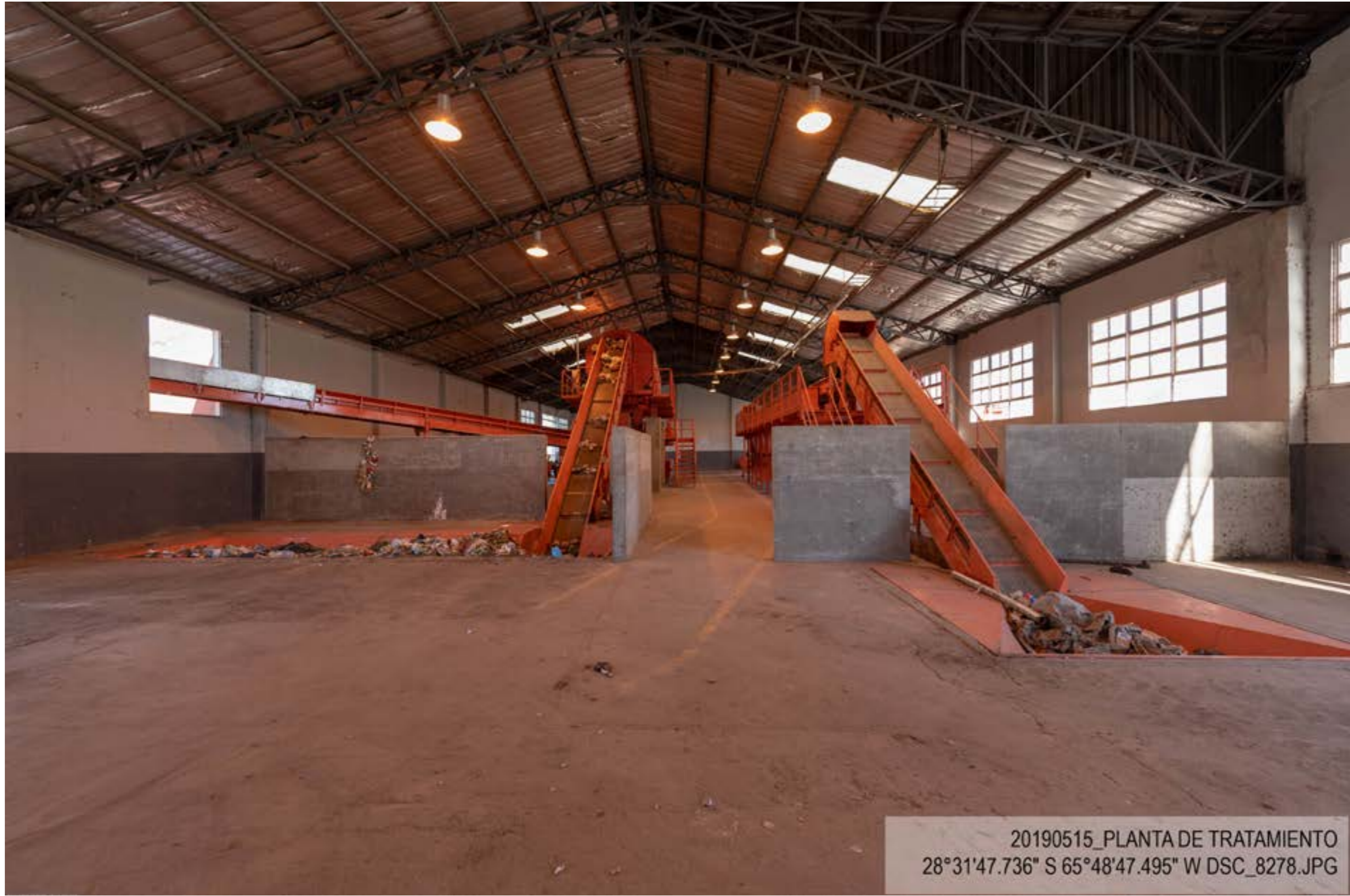
8.1 Planta de Separación de Residuos, Relleno Sanitario y Saneamiento de BCA
