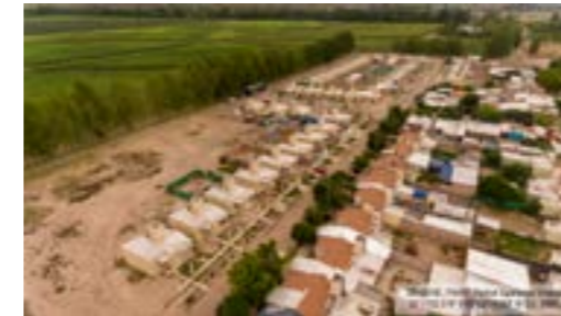
8.7 45 viviendas en calle La Picada S/N, Distrito Ugarteche, Lujan de Cuyo.
