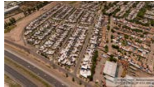
8.5 86 viviendas en calle Aristóbulo del Valle S/N esquina Vélez Sarsfield S/N de los Barrios ATSA VI y V, Distrito Las Tortugas, Godoy Cruz.
