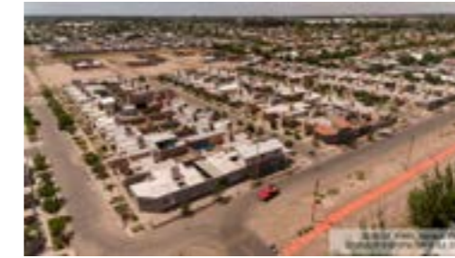
8.3 66 viviendas en Barrio Los Milagros (calle El Hornero S/N), Toribio Luzuriaga, Maipú. Lumaco, La Lagunita), Guaymallén.
