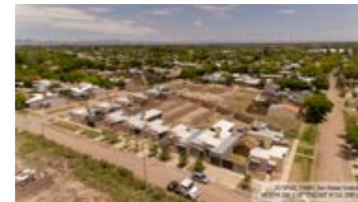
8.11 21 Viviendas en calle Islas Malvinas S/N del Barrio SITRAVI, Distrito Ciudad, San Rafael.
