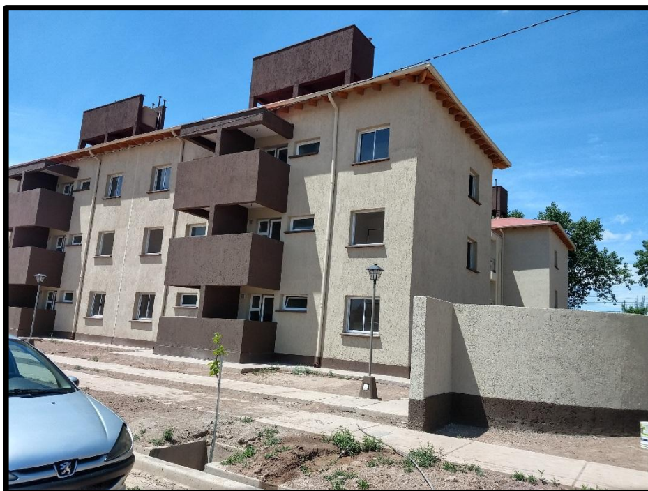
Foto 5: B° Lisandro Park. Falta de elementos de seguridad y oscurecimiento.
