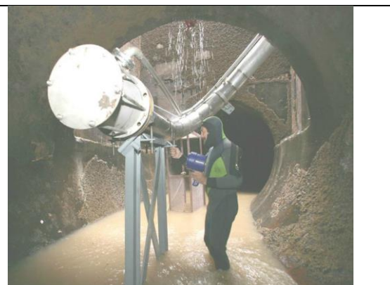
Boquilla de inyección de coagulante
