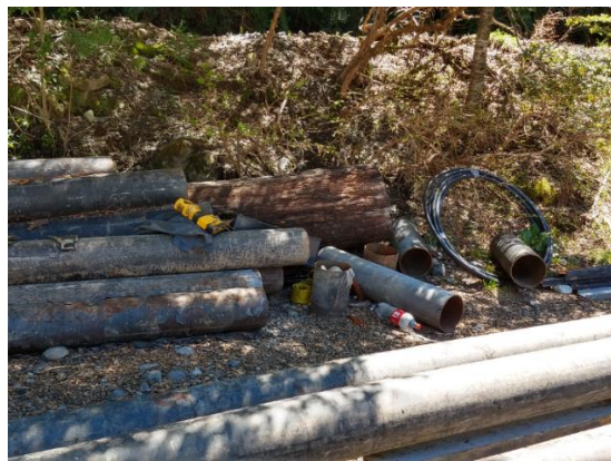
Foto 12: Material de obra descubierto y residuos, Puerto Alegre.
