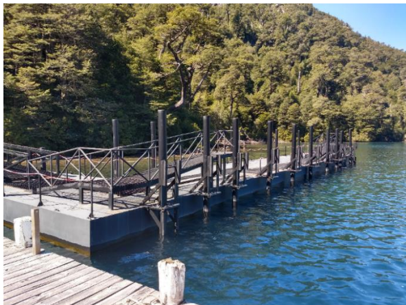
Foto 3: Muelle de pontones metálicos en Puerto Cántaros.
