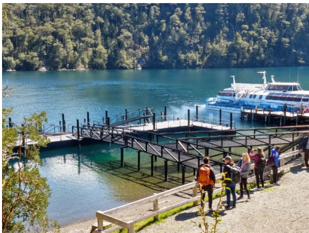
Foto 1: Muelle de pontones metálicos en Puerto Blest.
