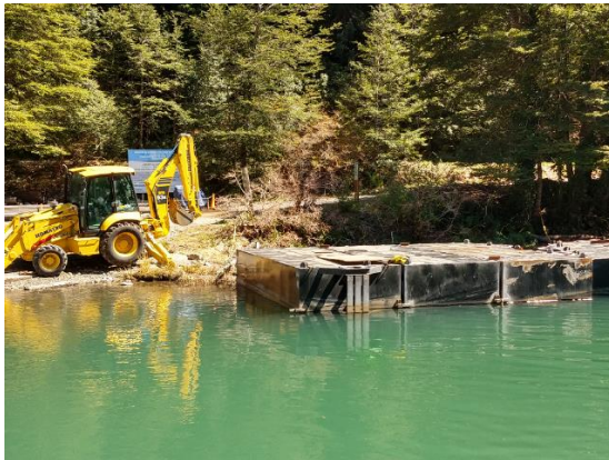
Foto 8: Muelle en construcción, Puerto Alegre.
