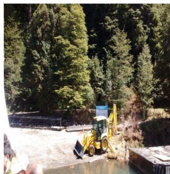
Retroexcavadora en Pto. Alegre
