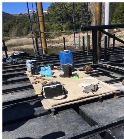
Foto 7: Materiales y otros elementos de obra, Puerto Frías.
