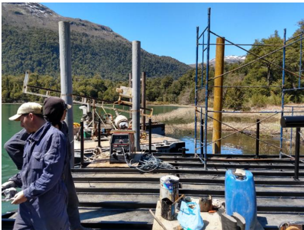
Foto 6: Obreros trabajando en muelle de Puerto Frías.
