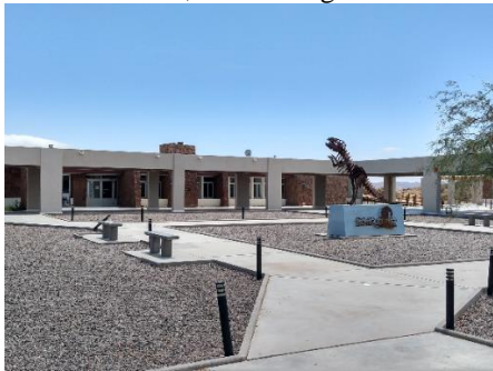
Foto 14: Plaza seca, área de confitería y sanitarios, P. P. Ischigualasto.
