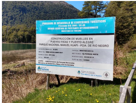
Foto 5: Puerto Frías. Zona de obra
