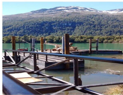
Pasarela en construcción muelle Puerto Frías
