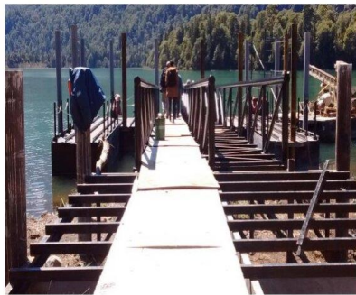
Pasarela en construcción muelle Puerto Frías
