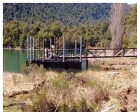
Estado actual de sector de movimiento de suelos
