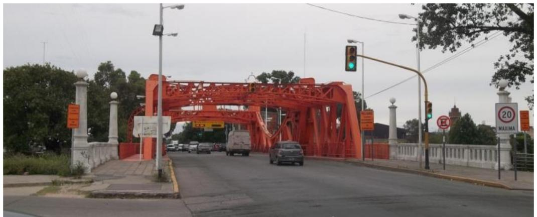
Estructura metálica a tablero inferior y vigas enrejadas. El conjunto se halla formado por dos tramos fijos laterales y uno móvil central de doble báscula tipo Scherzer.
