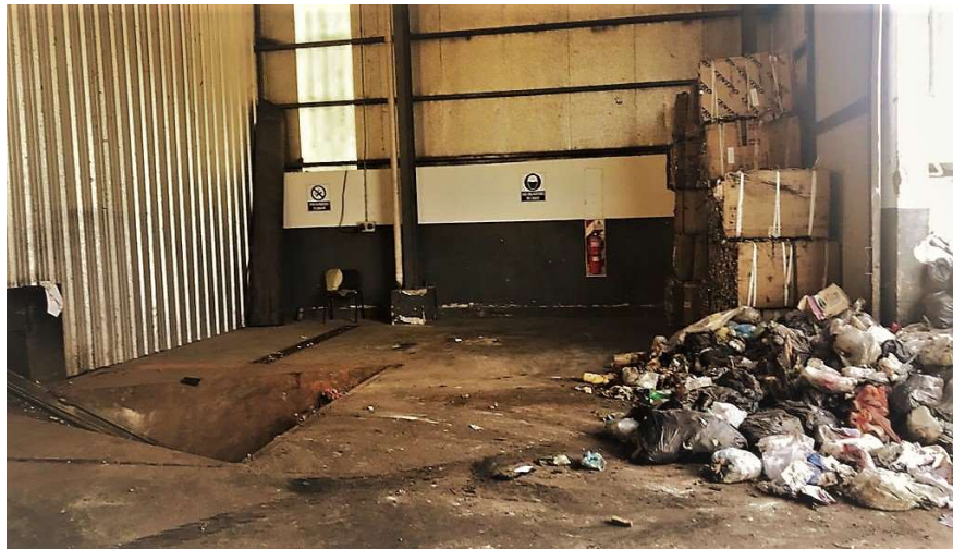
Foto 2: Tolva para el ingreso de materiales a la cinta de separación y clasificación de RSU.
