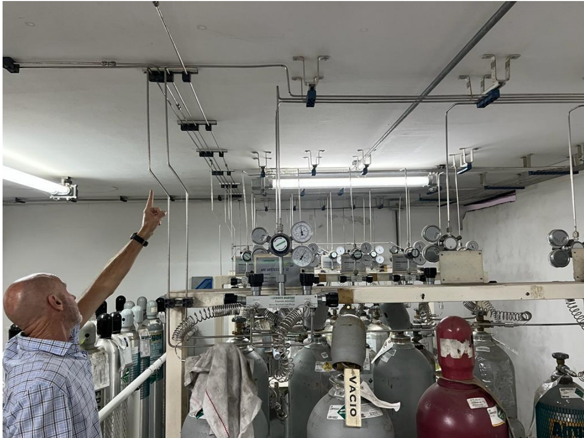
Figura IV.3. Sala de gases que se utilizan para la calibración y chequeo de los analizadores
