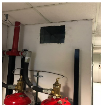
Fotografías N° 6 y 7, bocas de aire acondicionado sin rejilla
