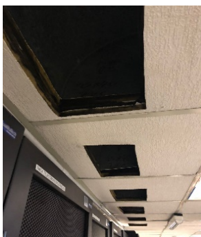
Fotografías N° 6 y 7, bocas de aire acondicionado sin rejilla
