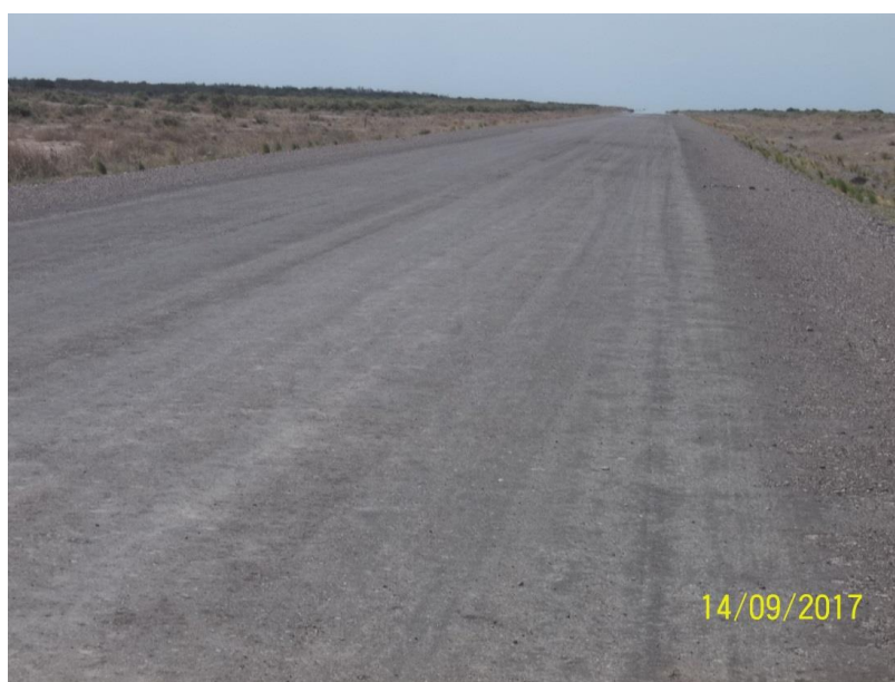
Imprimación y desgranamiento del sector
